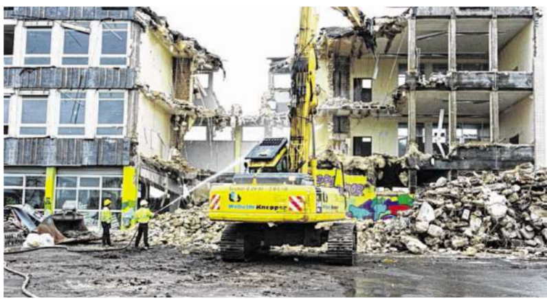
Der Abriss der Hauptschule auf der Liester läuft; hier entsteht die neue Pflegestation nebst Tagespflege und betreutem Wohnen. Foto: J. Lange
